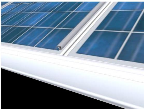
Im nächsten Schritt werden die auf Länge geschnittenen Vertikaldichtungen bis zum Anschlag in die Klebemasse eingesetzt.
