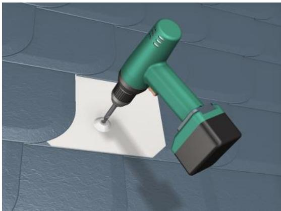
Die Solarbefestiger müssen direkt in die Dachpfetten oder Sparren eingeschraubt werden.
