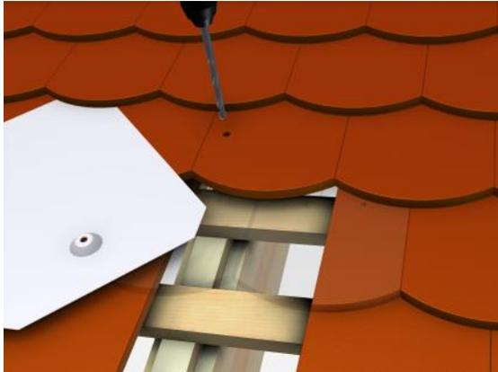
Die Befestigung in der Dachkonstruktion erfolgt über ein Formblech und den „Solarbefestiger mit Dichtung“.
