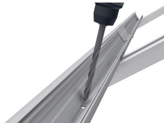
Bei den Horizontalprofilen müssen, wenn nicht vorhanden oder überbaut, vor dem Einsetzen der Module Entwässerungsöffnungen in modulbreiten Abständen gebohrt werden. ( $\varnothing$  ca. 10 mm)
