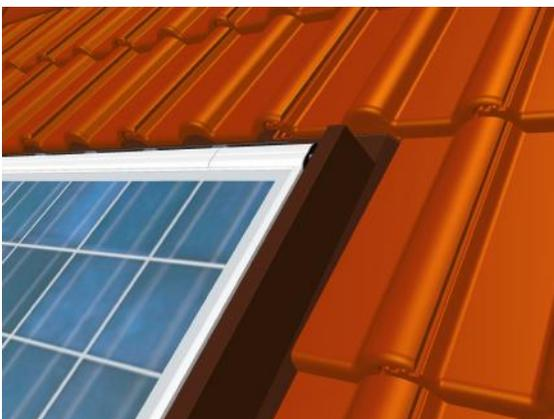
Anschließend kann die Dacheindeckung vorgenommen werden. Im seitlichen Bereich kann es ggf. dazu kommen, dass Teile der Dacheindeckung zugeschnitten werden müssen. Abschließend werden die Pfannen aufgelegt.
