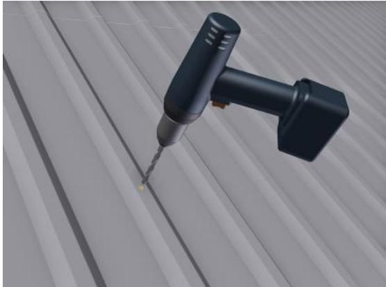
Die Befestigung in der Dachkonstruktion erfolgt über den „Solarbefestiger mit Kalotte“.
